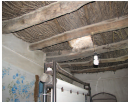
شکل ۱۸- روشنایی مصنوعی در کارگاه
